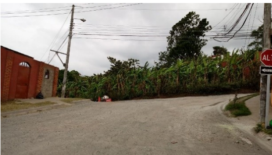
Imagen 2 Mejora de la capa base en Lomas de Cabeara
